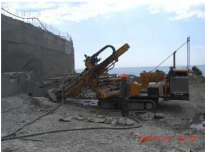
В скальных грунтах перед установкой анкера скважина должна быть испытана на водонепроницаемость.
