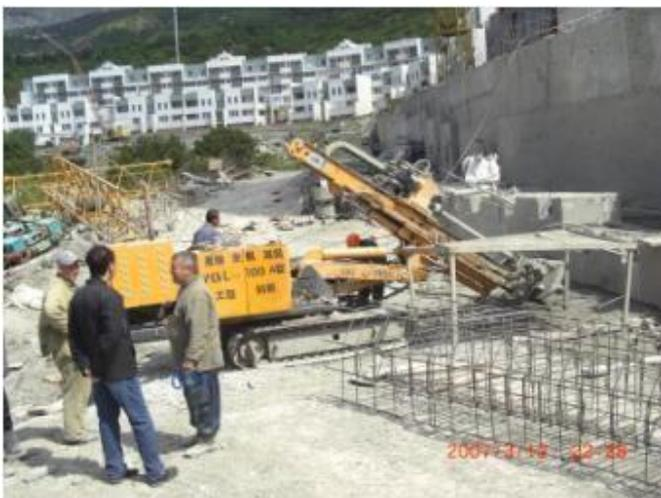
Способы бурения скважин должны предусматривать мероприятия, снижающие разуплотнение грунта стенок скважин.
