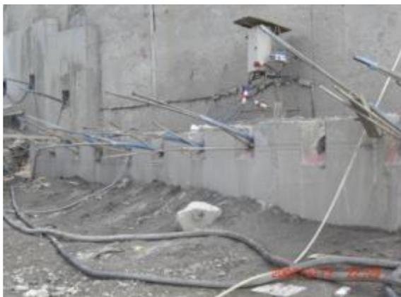
Контрольным испытаниям следует подвергать первые три анкера в каждом новом слое грунта и каждый 10-й из последующих, установленных в данном слое грунта.
